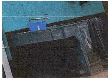
Foto 2: mejoramiento de muro perimetral( cerco)
