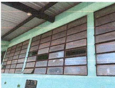
Foto 3: Mejoramiento de vidrios
