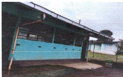
Foto 4: mejoramiento de canales y aguas pluviales
